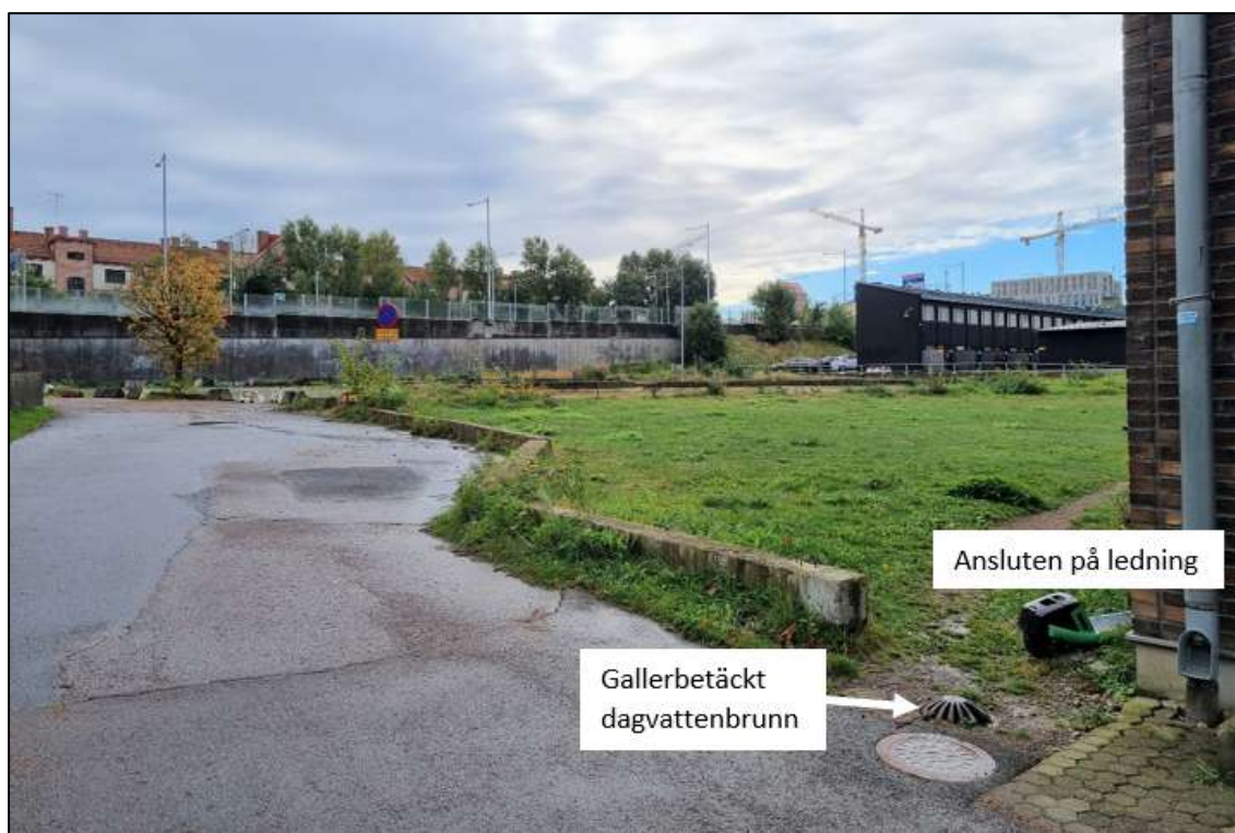
Figur 4. Bild över större delen av planområdet, gallerbetäckt dagvattenbrunn och takavvattning för befintlig byggnad utanför planområdet.
