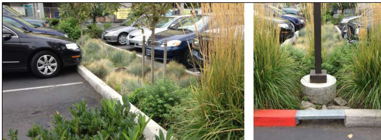
Figur 26. Exempel på nedsänkt växtbädd på en parkeringsplats, i dessa anläggningar leds dagvatten in i växtbädden via öppningar i kantstenen (Stockholm vatten och avfall, 2024).
